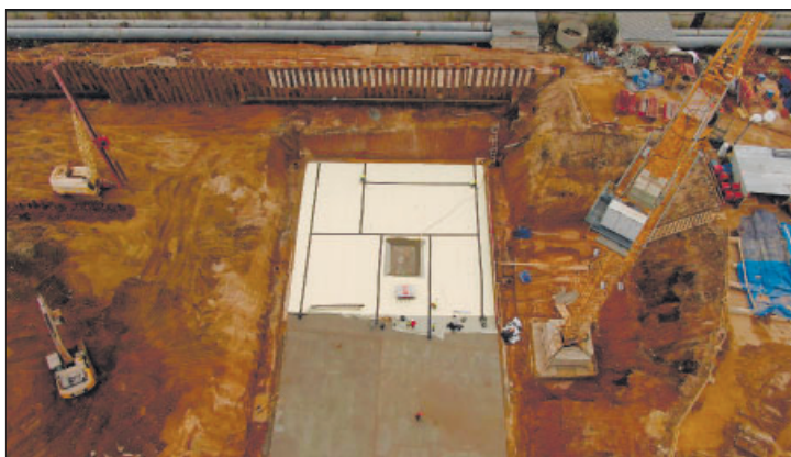
Рис. 1. Примеры строительства высотных зданий (класс КС-3) в Москве с применением гидроизоляционных ПВХ-мембран LOGICBASE™ в укрепленных котлованах
