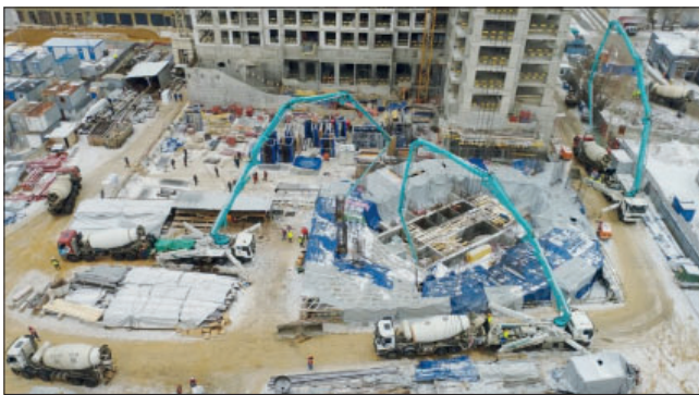
Рис. 6. Бетонирование распределительной балки-плиты Fig. 6. Distribution beam-slab concreting
