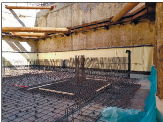
Рис. 1. Примеры строительства высотных зданий (класс КС-3) в Москве с применением гидроизоляционных ПВХ-мембран LOGICBASE™ в укрепленных котлованах
